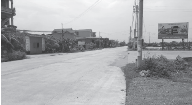
Hình 3.1: Các tác giả thị sát tại km39+500 tuyến QL12B kéo dài sử dụng vật liệu đolômit đắp nền đường
